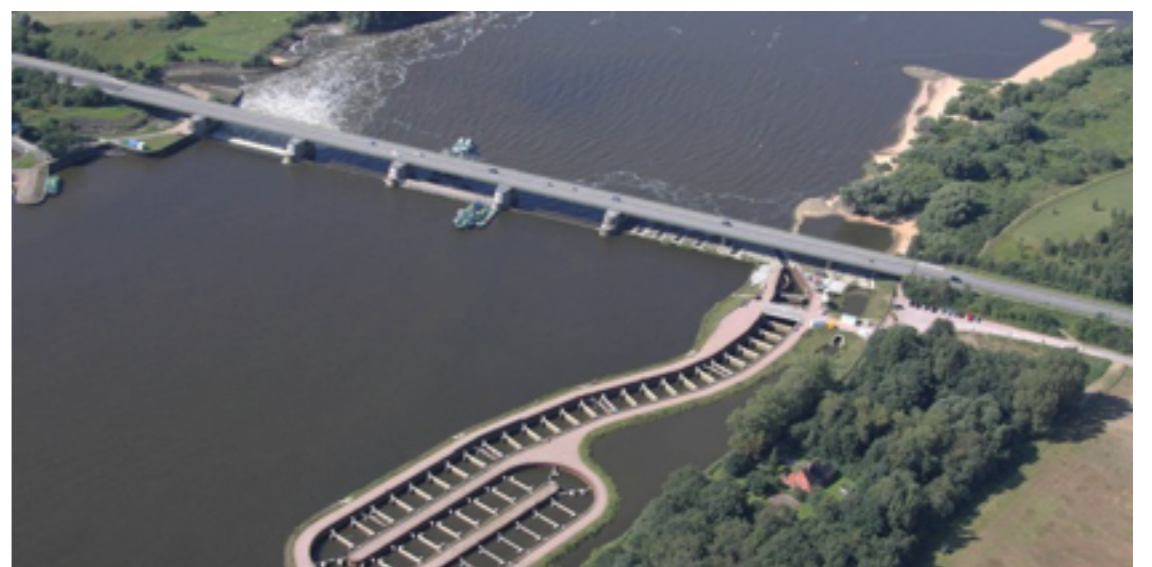
Das Stauwehr Geesthacht aus der Luft. Foto: tja
